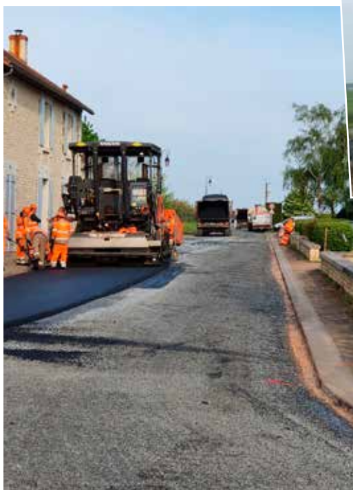
Travaux de voirie rue de la Gare
