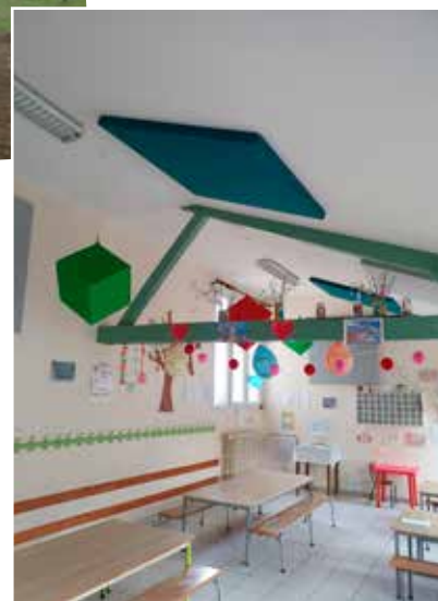
Travaux d'insonorisation de la cantine
