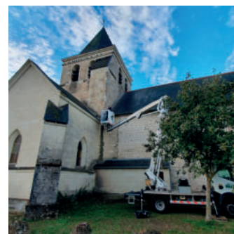
Obturation toiture église
