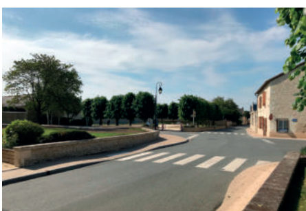
AMÉNAGEMENT DU CENTRE-BOURG
