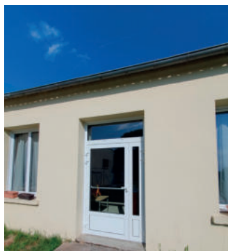
Remplacement porte école du Haut Crué
