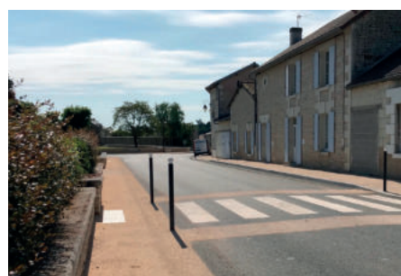
AMÉNAGEMENT DU CENTRE-BOURG
